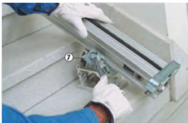
Монтаж рельсовой опоры для угловой/ступенчатой резки
